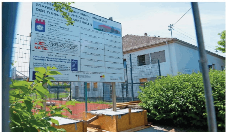
Turnhalle und Markthalle in der Ottweiler Straße im Alten Weiher werden von Grund auf saniert.
